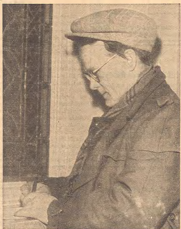
Har man skrivit ordentlig kladd hemma är det enkelt att åstadkomma en hygglig dublett i en hast, tyckte byggnadsarbetare Sven Eriksson och intog en tämligen bekymmerslös skrivställning i en fönstersmyg på Stadshuset.
